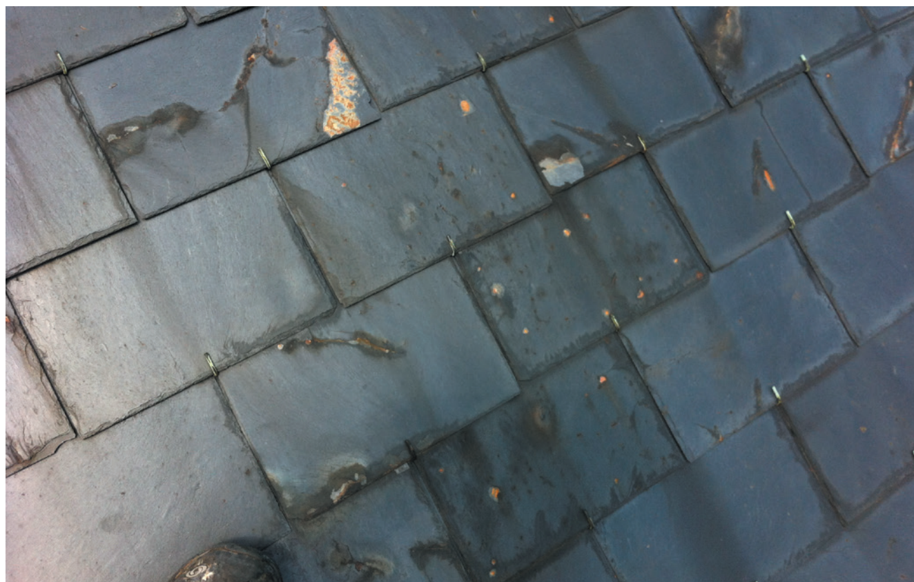
Ardoises posées non conformes
