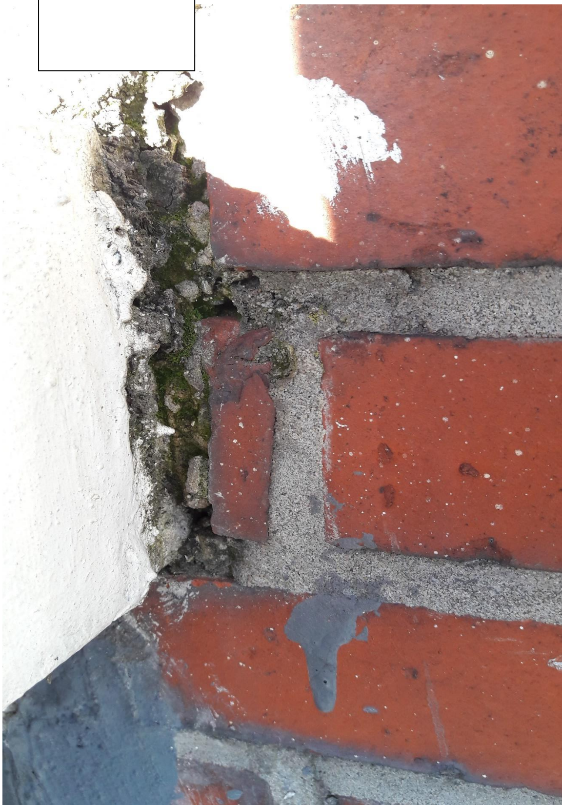
Photo 16: constats visuels, 1-ier étage : la façade est en mauvais état, de l'eau pluviale peut infiltrer dans le mur – vue sur ??
