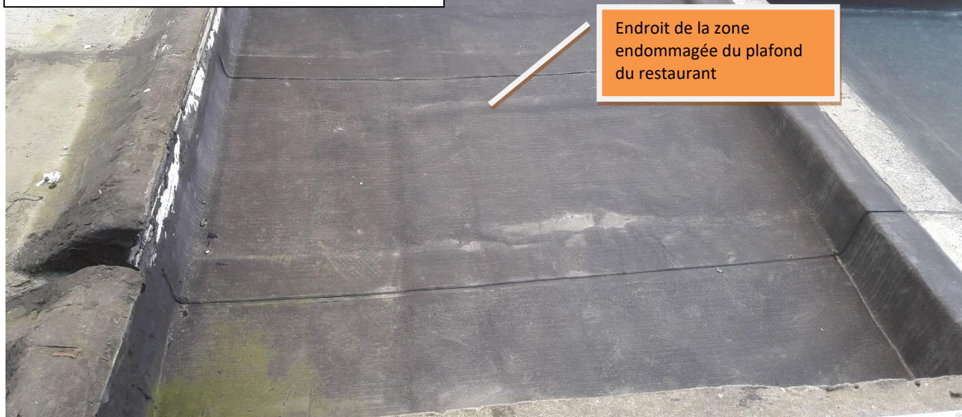
Photo 4 : constats visuels, toit plat au-dessus du restaurant : le solin du roofing du toit à côté du restaurant est en mauvais état
