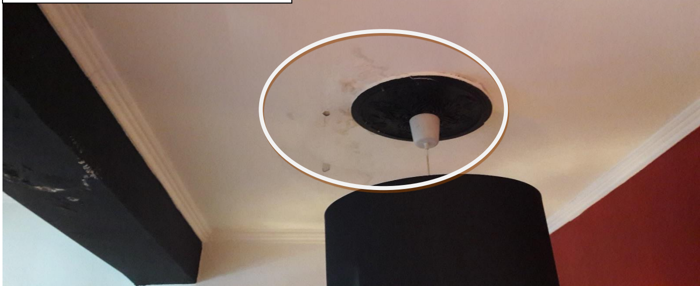
Photo 2 : constats visuels, rez de chaussée, restaurant : il y a des dégâts des eaux au plafond.
