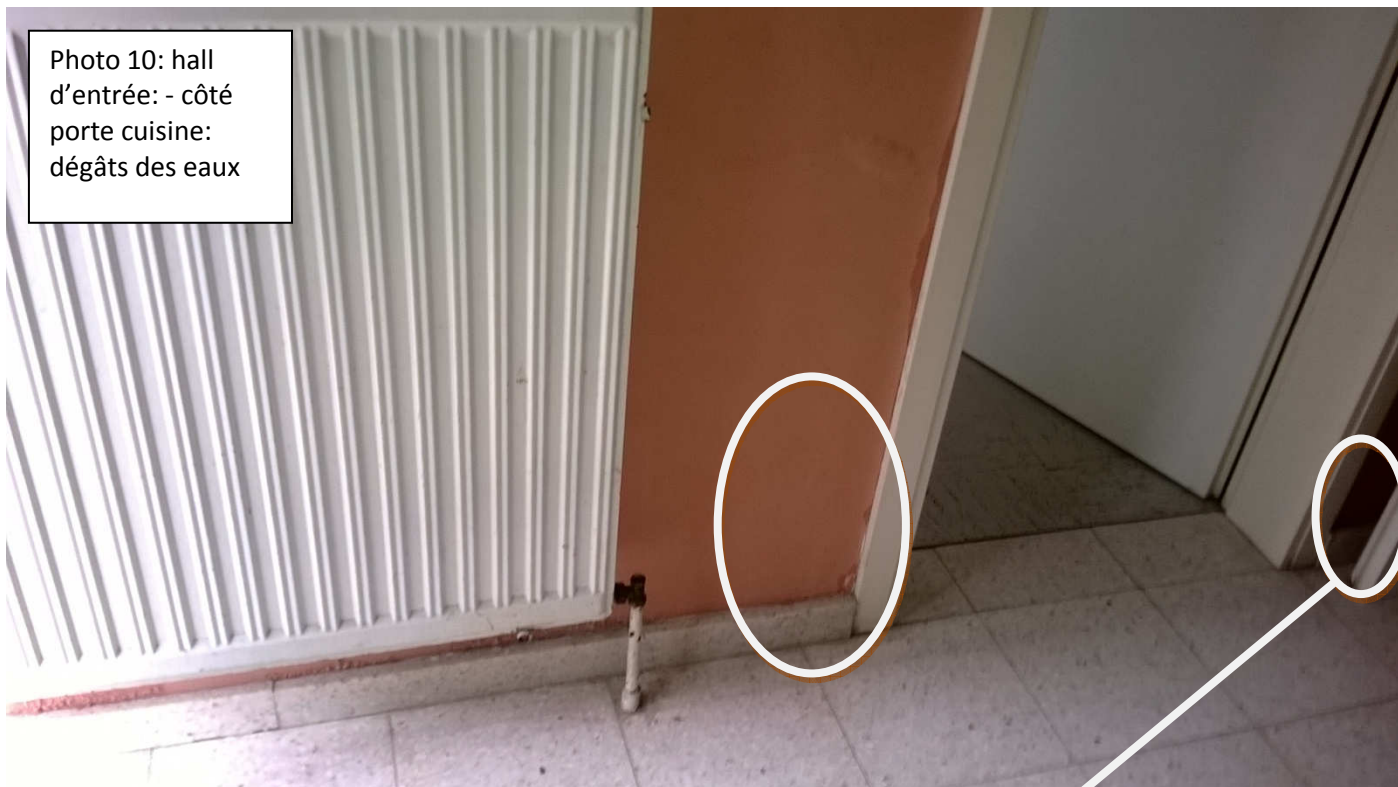
Photo 11: hall d'entrée: - côté porte cuisine: dégâts des eaux
