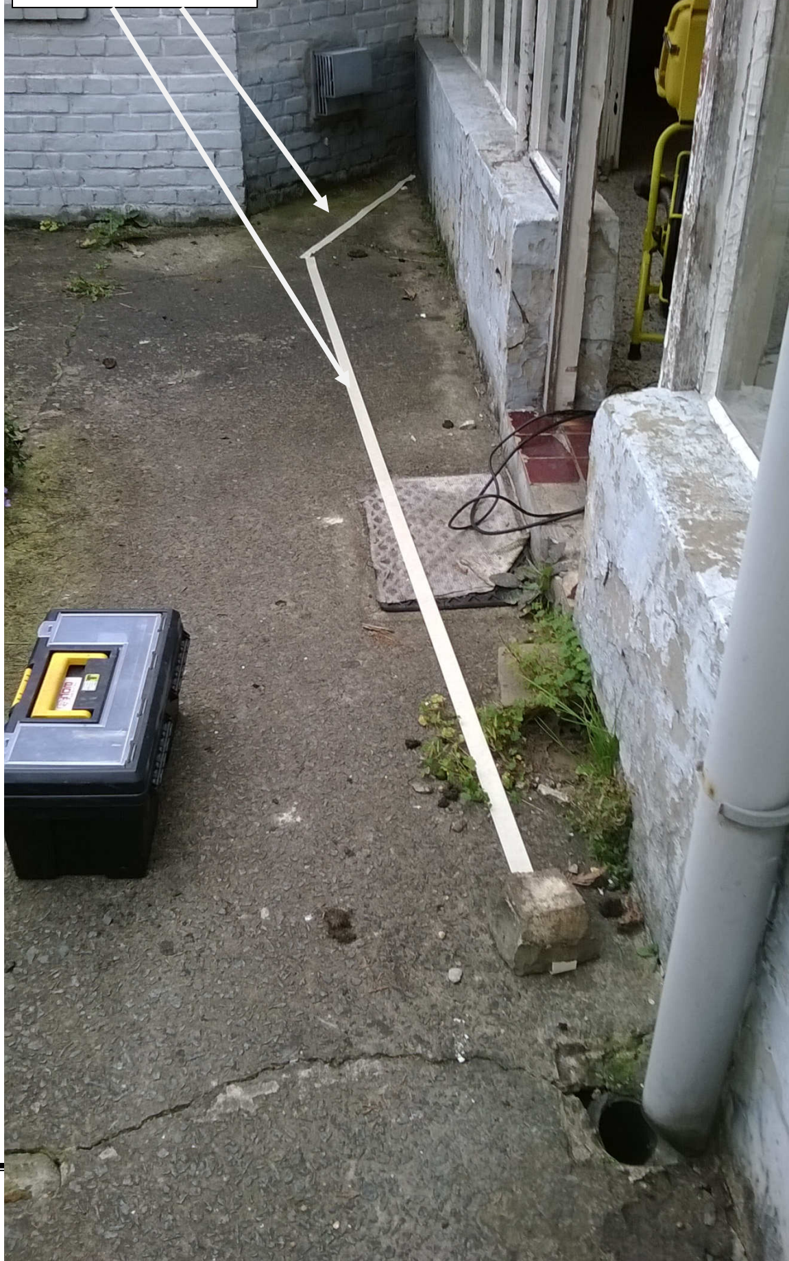
Photo 20: façade arrière: cheminement de la décharge d'eau pluviale marqué sur le sol
