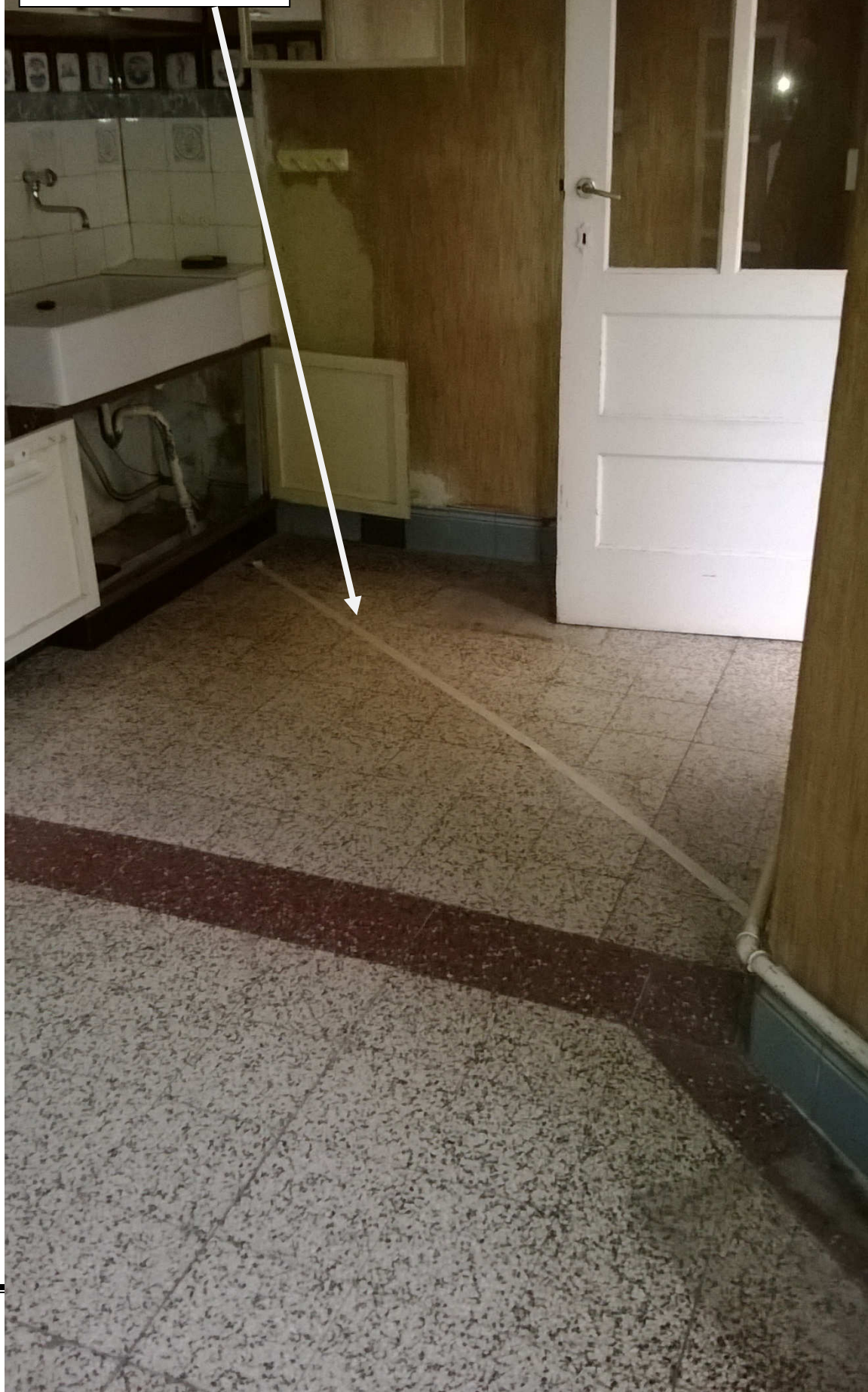
Photo 19: cuisine: cheminement de la décharge de l'évier marqué sur le sol
