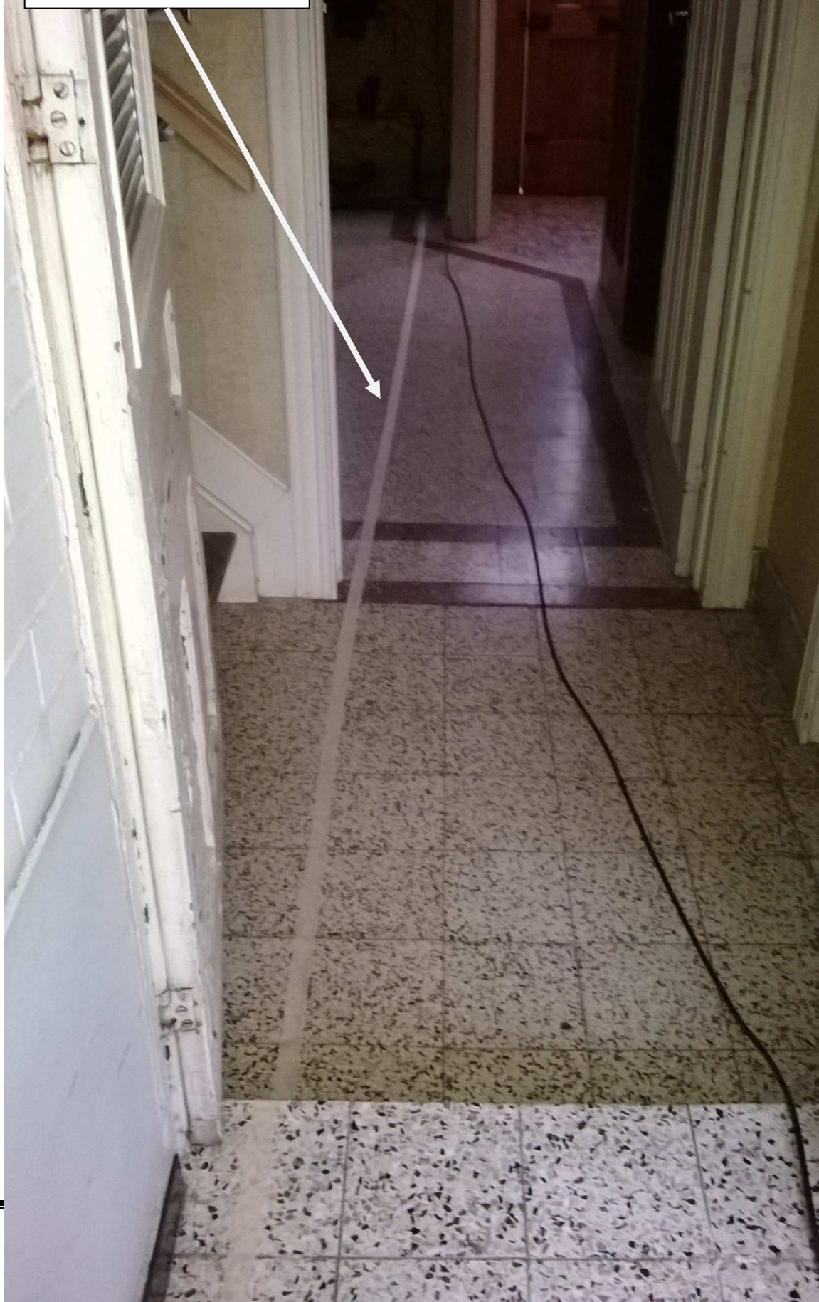
Photo 29: véranda: cheminement de la décharge principale entre véranda et pièce avant, marqué sur le sol
