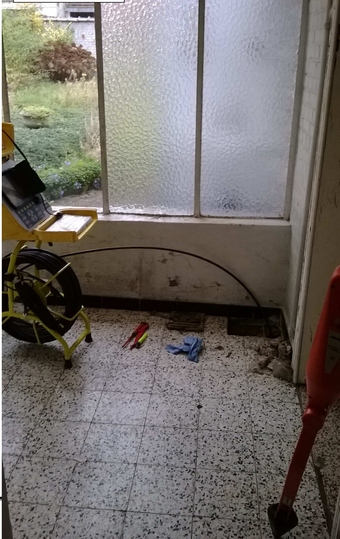
Photo 22: véranda: introduction de la caméra endoscopique à côté du sterfput
