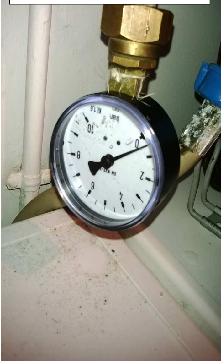
Photo 10: test de pression sur le circuit 1 sanitaire eau froide buanderie/cuisine : fin du test – petite perte de pression : fuite sur le circuit – le test a été effectué à 3 reprises avec un même résultat
