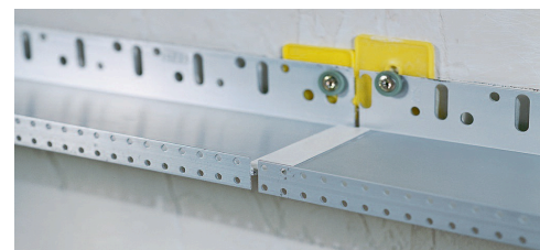
Fig. 129 Bandes de renfort d'environ 300 x 300 mm (mouchoirs) placées à la jonction entre des profils dépourvus de treillis soudé.
