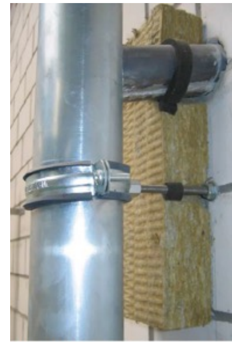
11 Pose d'une bande comprimée (fond de joint) à la jonction entre le panneau isolant et le percement de l'ETICS.
