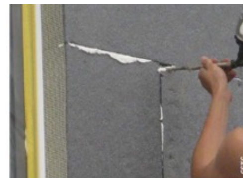
fig. 121 Remplissage des joints entre panneaux au moyen d'une mousse PU expansible adaptée.
