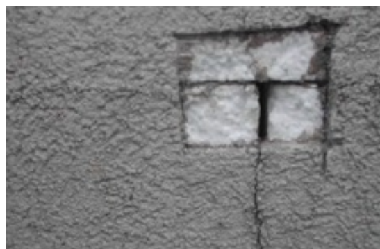
Fissure observée le long d'un joint ouvert entre les EPS
